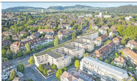
Beton Projekt «Läbe im Burgereziel» wurde Beton mit recyceltem Betongranulat und gespeichertem CO 2 verwendet. Bild: Losinger Marazzi.
