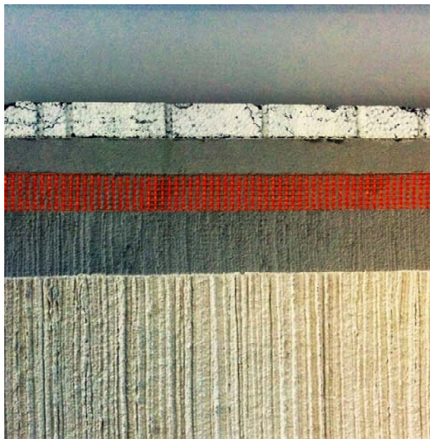
Abbildung 2: Ansicht des Aufbaus WDVS ohne Dübel
