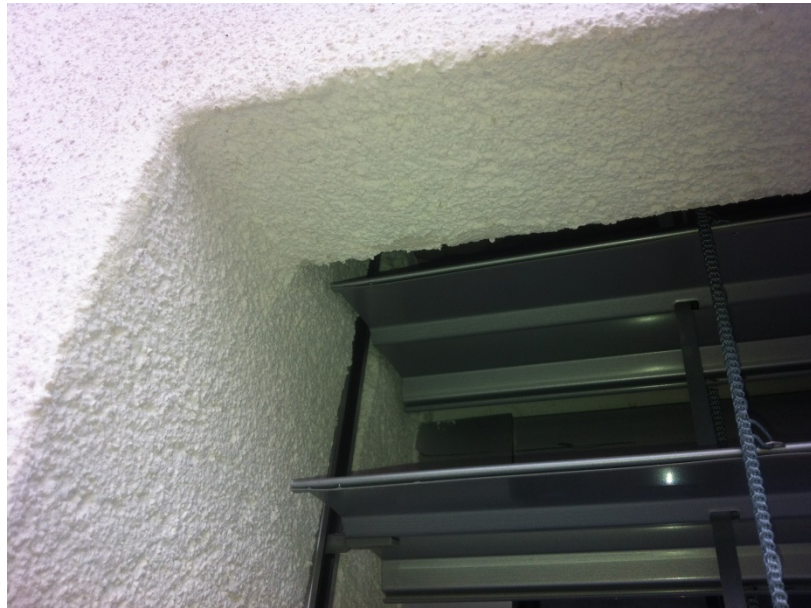
Abbildung 17: Führungsschiene der Lamellen-Storen
