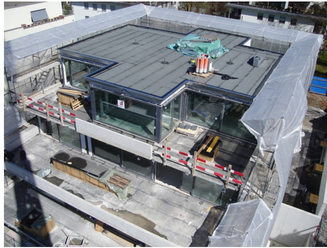
Abbildung 22: Wetterschutz mit Kunststoffbahnen
