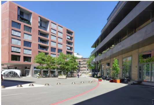
Abb. 34: Hofbereich Sieb 10/ Lofts G48, e.F.
