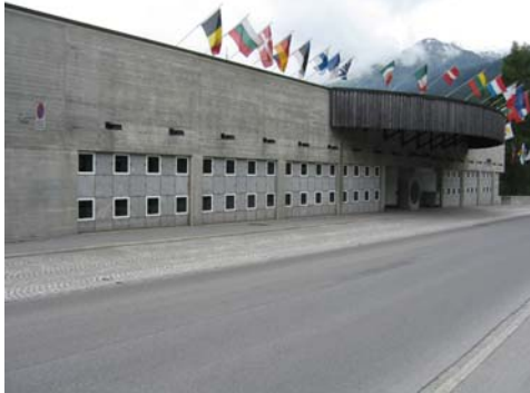
Bild 4: Kongresszentrum, Davos Platz Geschlossene Fassade zur Hauptstrasse
